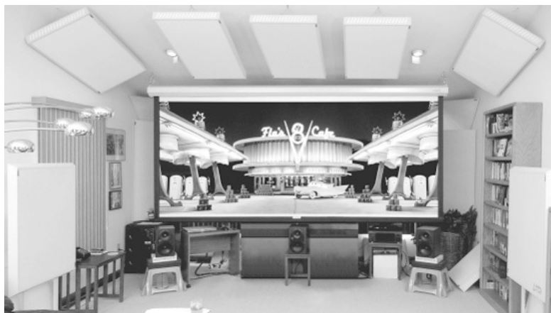
Hình 19.7: Tấm hình này cho thấy mặt trước phòng hát trong phòng khách Ethan. Tấm hấp thụ gắn ở bên trái và phải xử lý phản dội bên, và ba tấm nữa treo dưới trần nhà. Bẫy bass nằm ở góc tường phía trước bên trái và phải, và đặt nhiều bẫy bass ở trên cao tường, bên trong góc tường trần.
