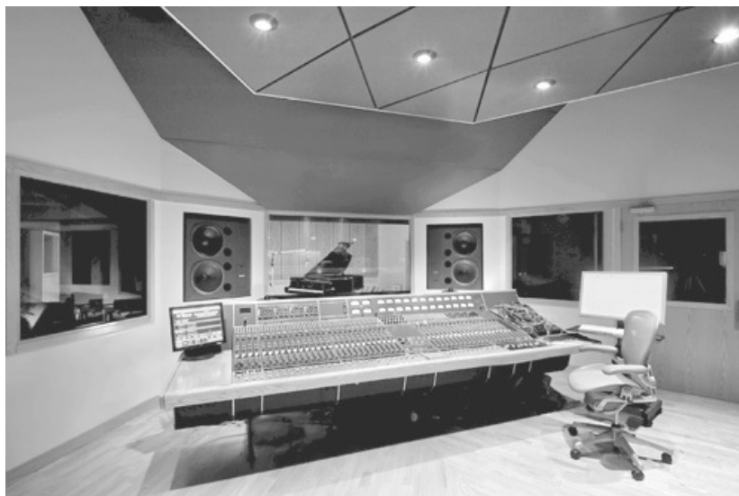
Hình 19.13: Phòng điều khiển này xử dụng góc tường bên để hướng phản dội sớm ra khỏi vị trí nghe đến phía sau phòng. Tuy nhiên, trần phía trên bàn điều khiển cần hấp thụ hơn là phản dội để thêm bass.
